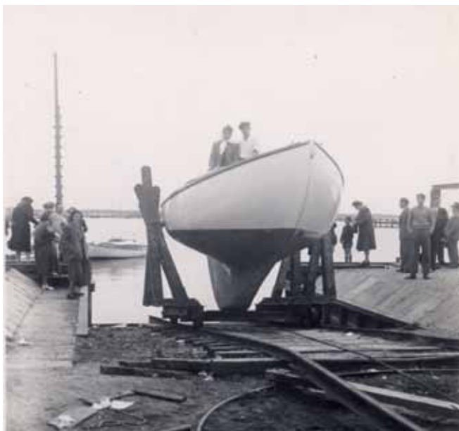
Søsætningen af Heto. De tunge skinner blev flyttet rundt med håndkraft og beddingvognen blev ligeledes skubbet udelukkende med håndkraft
